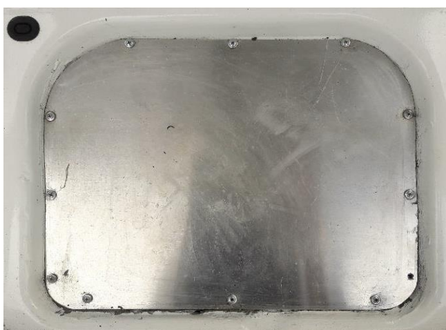
Rys. 1.2 Zaślepiony otwór po wnęce akumulatora
